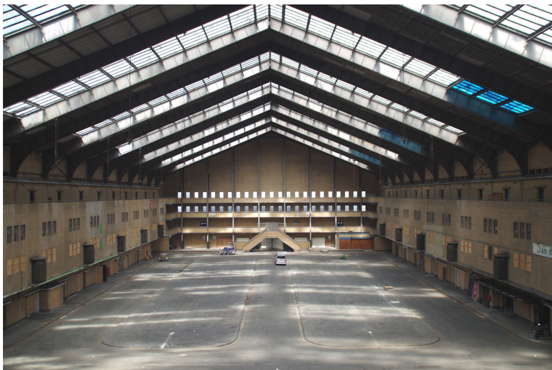
3) Interieur richting het noorden van de Centrale Markthal te Amsterdam uit 1931-1934 met een overspanning van 50 meter en een dakconstructie met geklonken vollewandliggers (foto auteur 2017)
