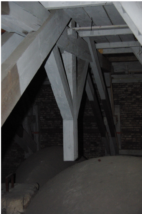
2b) (l) Spant type B met onderbroken schoren, lijkend op een springwerk (foto auteur 2012)
