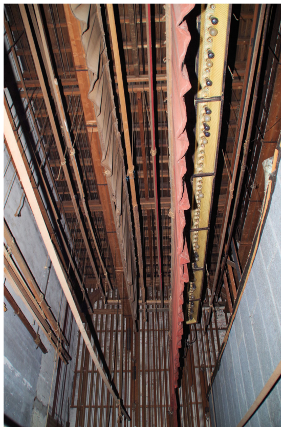
2) Deel van in 1924 toegevoegde toneeltoren met trekken en trekkenwand in de JT-bioscoop in Hilversum. (foto auteur 2015)
